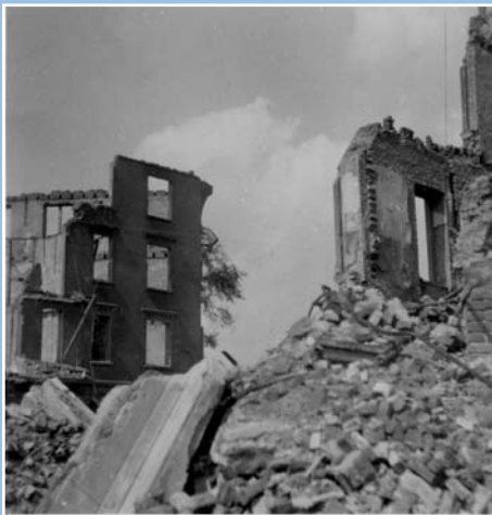
Sprengung von Bauruinen, 1947 Archiv Marien-Hospital
