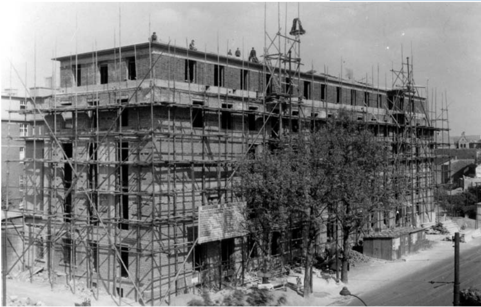
Richtfest Hauptgebäude, 1950 Archiv Marien-Hospital
