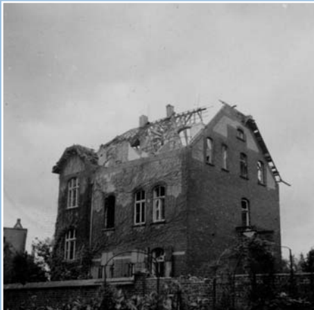
Zerstörtes Isolierhaus, 1945 Archiv Marien-Hospital
